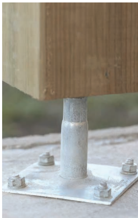
PIEDS DE POTEAU
